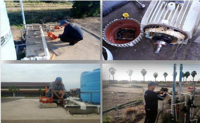
**Figura 20** Mantenimiento preventivo a bombas de suministro de agua en edificios y áreas verdes
